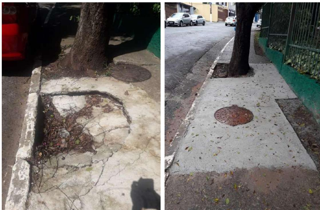
Figura 42: Reparos no vazamento e reconstrução do calçamento
