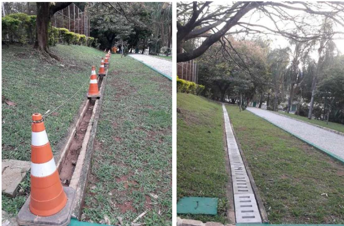
Figura 40: Reparo e instalação de novas grelhas
