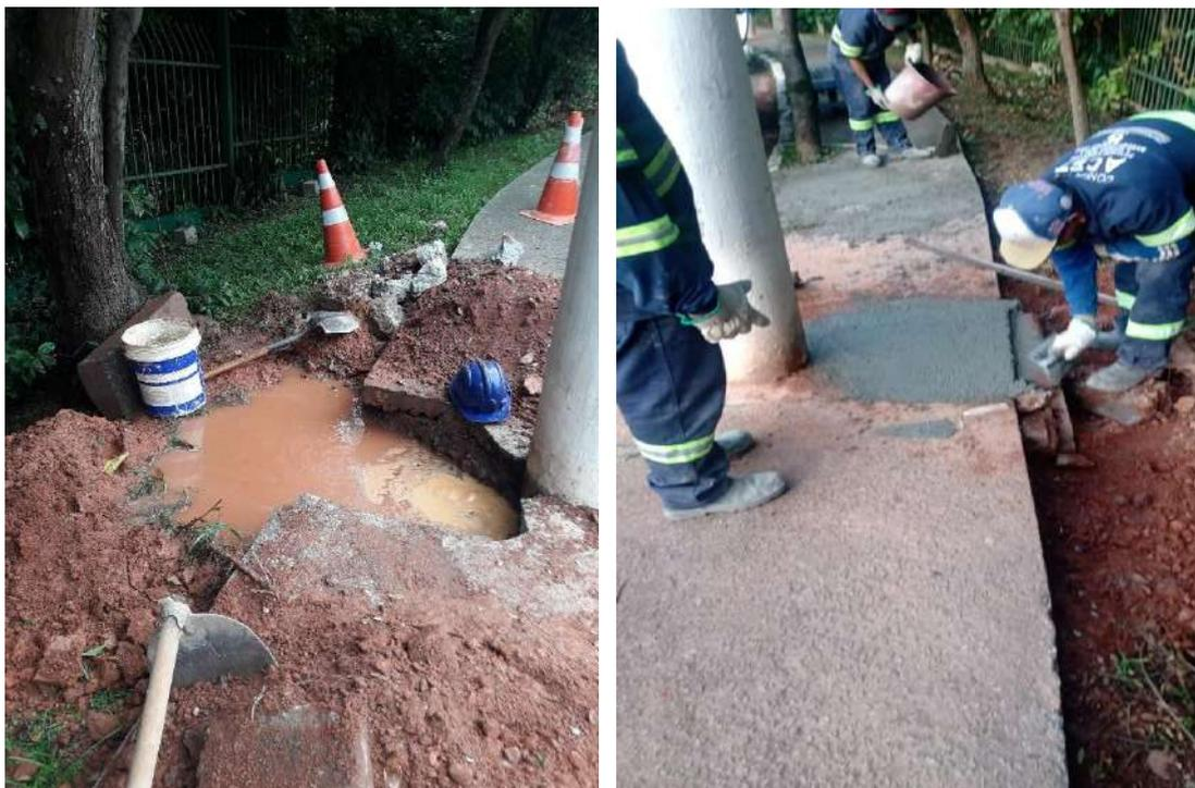
Figura 41: Reparos no vazamento e reconstrução do calçamento
