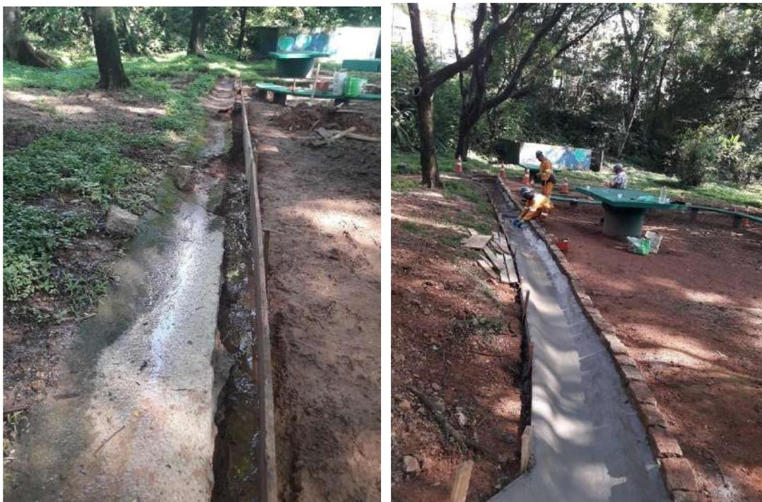
Figura 31: Reforma de canaletas de drenagem
