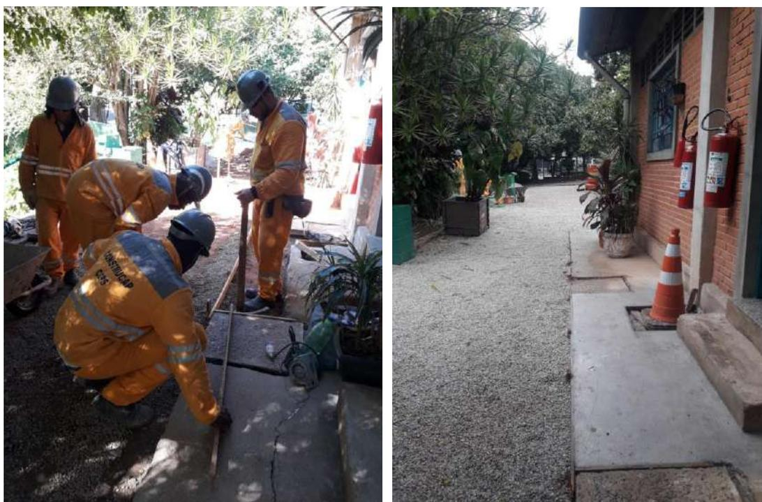
Figura 37: Adequação de calçamento (antes e depois)
