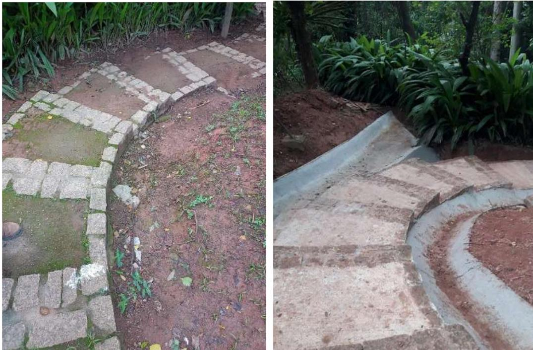
Figura 30: Reforma de escada e sistema de canaletas de drenagem (antes e depois)
